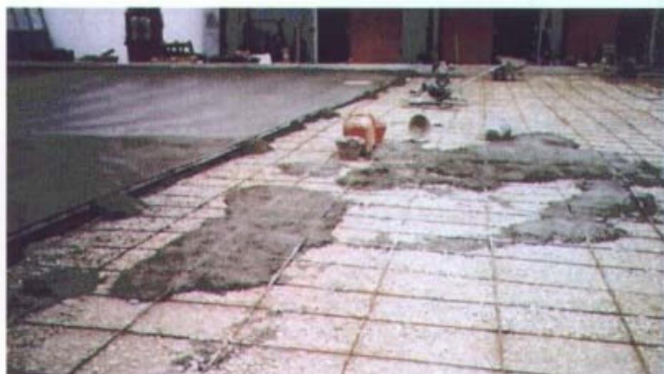
Fig. 1 Posa in opera direttamente sulla massicciata dell'armatura di una pavimentazione industriale
