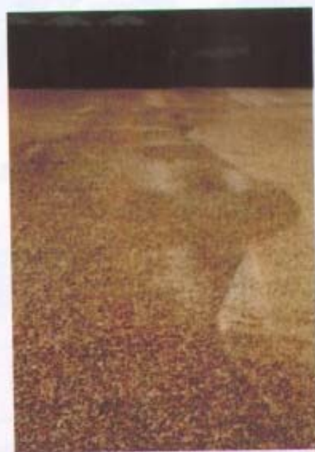
Fig. 18 Macchie bianche e difetti di colorazione della pavimentazione
