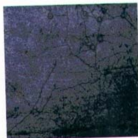
Fig. 14 Reticolo di cavillature e impronte circolari
