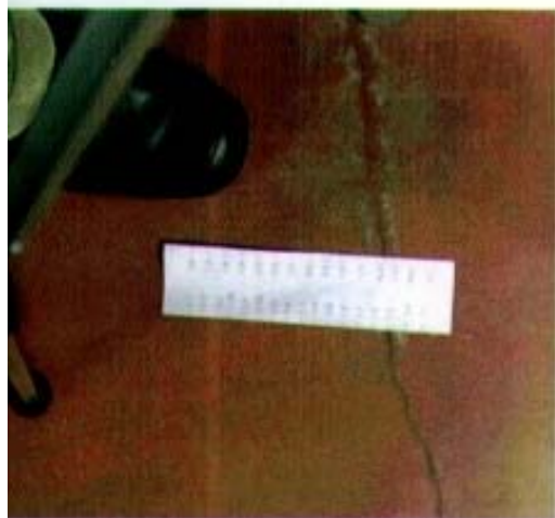
Fig. 4 Fessura lineare da 1.3 mm
